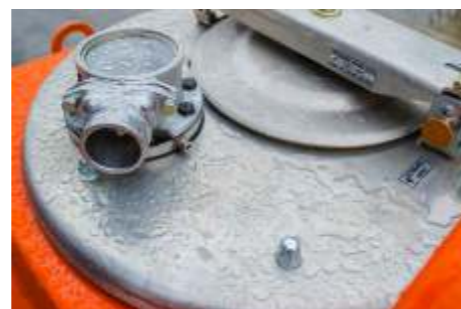
Алюминиевый заливной люк с дыхательным устройством УД-2-80
